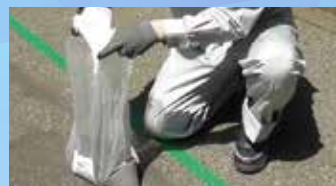
STEP2 骨材袋に樹脂を投入
